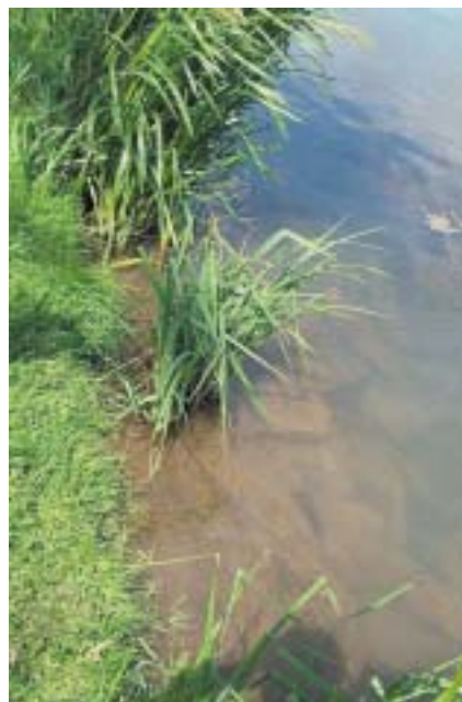
Dégradation de la berge aménagée du fait du passage de la faune et du piétinement des pêcheurs. Les plantes coloniseront à nouveau cette petite zone: il n'y a pas besoin d'intervention
