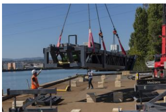
Les hydroliennes en cours de montage au Port de Lyon Edouard Herriot (photos HD disponibles sur demande)
