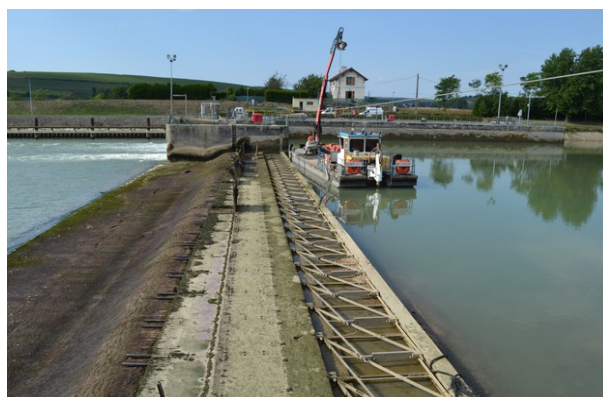
Barrage de Charly-sur-Marne mis à sec
