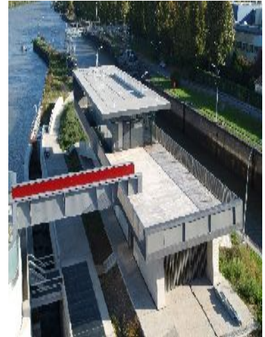
Cabine de commande et passe à poisson
