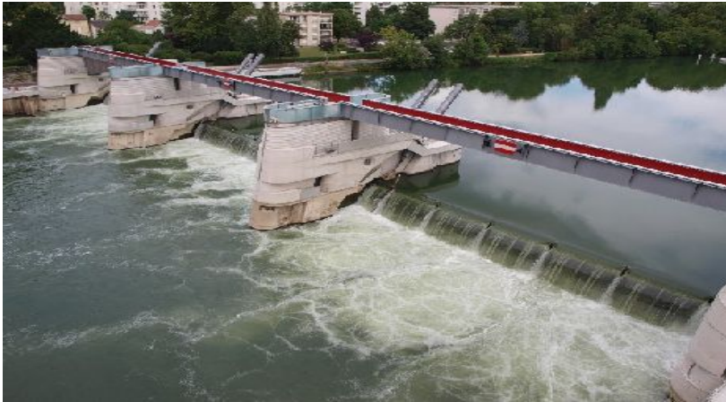
Nouveau barrage de Chatou: moderne et épuré
