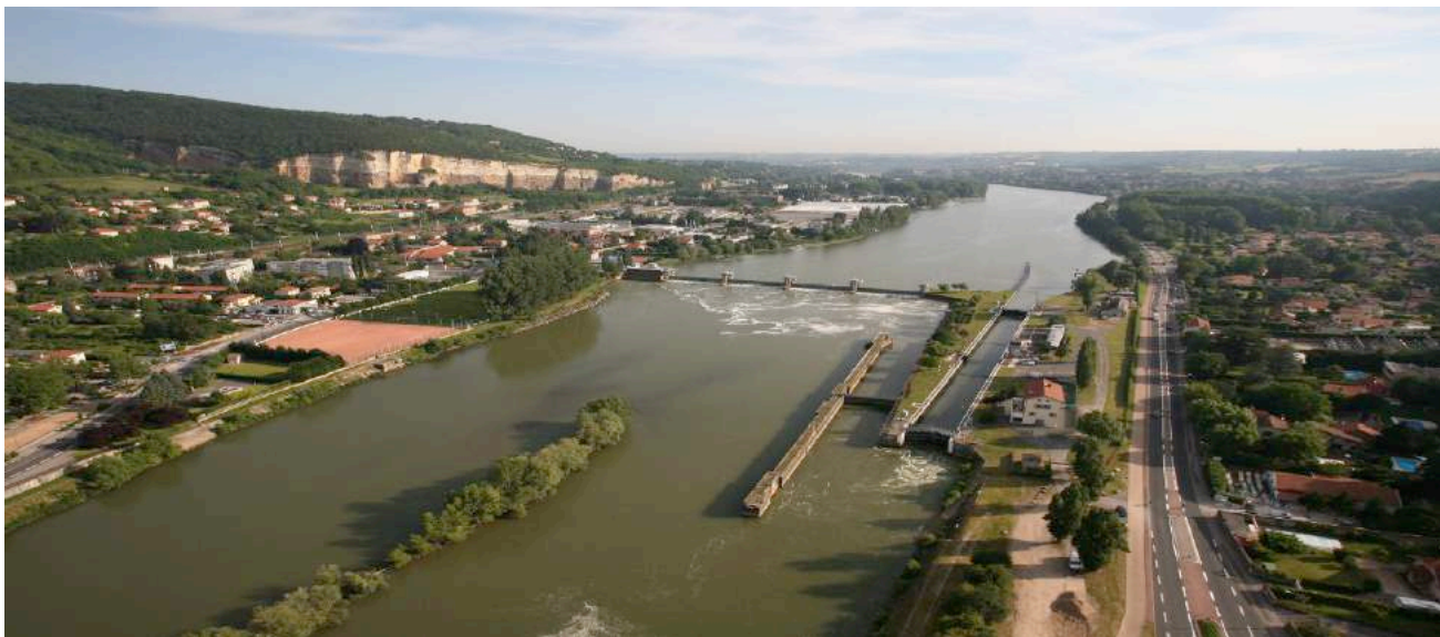
Vue aérienne de l'écluse de Couzon avant les travaux
