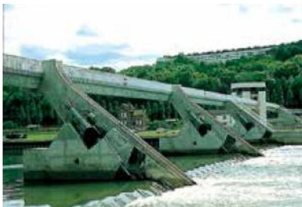
Figure 2 : barrage à clapet
