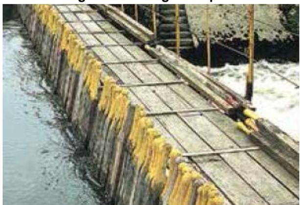
Figure 4 : barrage à fermettes et aiguilles
