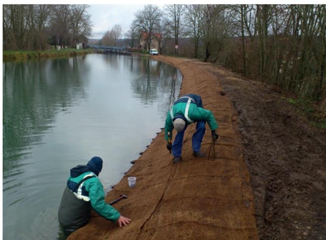
*Défense de berges, fixation des géotextiles à Bras-sur-Meuse (Meuse)*
