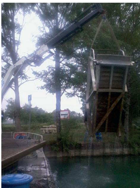
*Enlèvement d'un ponton d'accostage et de sa passerelle à Pouilly-sur-Meuse (Meuse)*
