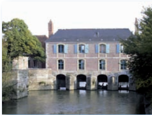
Le grand vannage à Arques
