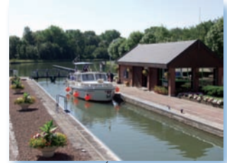
Écluse de Crèvecoeur
