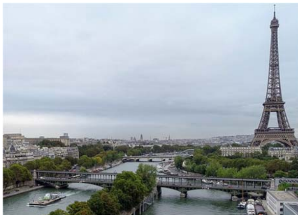
Navigation aux abords de la Tour Eiffel (Paris 7 e )
