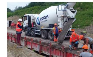
Réalisation des poutres de couronnement en béton sédiment pour la réflexion des berges de Goeulzin
