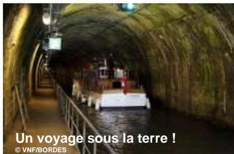
Le tunnel de Balesmes est un ouvrage d'art remarquable du canal entre Champagne et Bourgogne, construit en 1880 et 1883. D'une longueur de 4820 m pour une largeur de 8 m et une hauteur sous clé de 10 m, il est le quatrième tunnel fluvial de France par sa longueur et permet de réduire considérablement le nombre d'écluses sur la voie d'eau.
