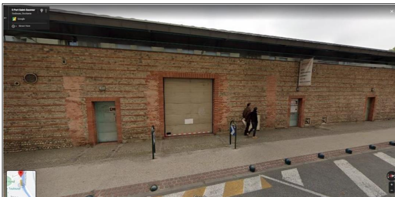
Figure 12: Accès au local de la capitainerie par la route (traversée de la piste cyclable).
