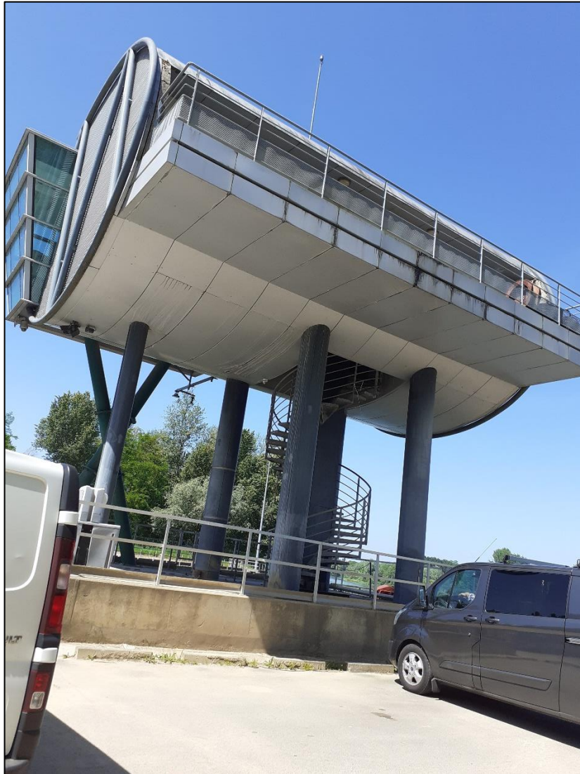
Figure 19 : Tour de contrôle sur pilotis.
