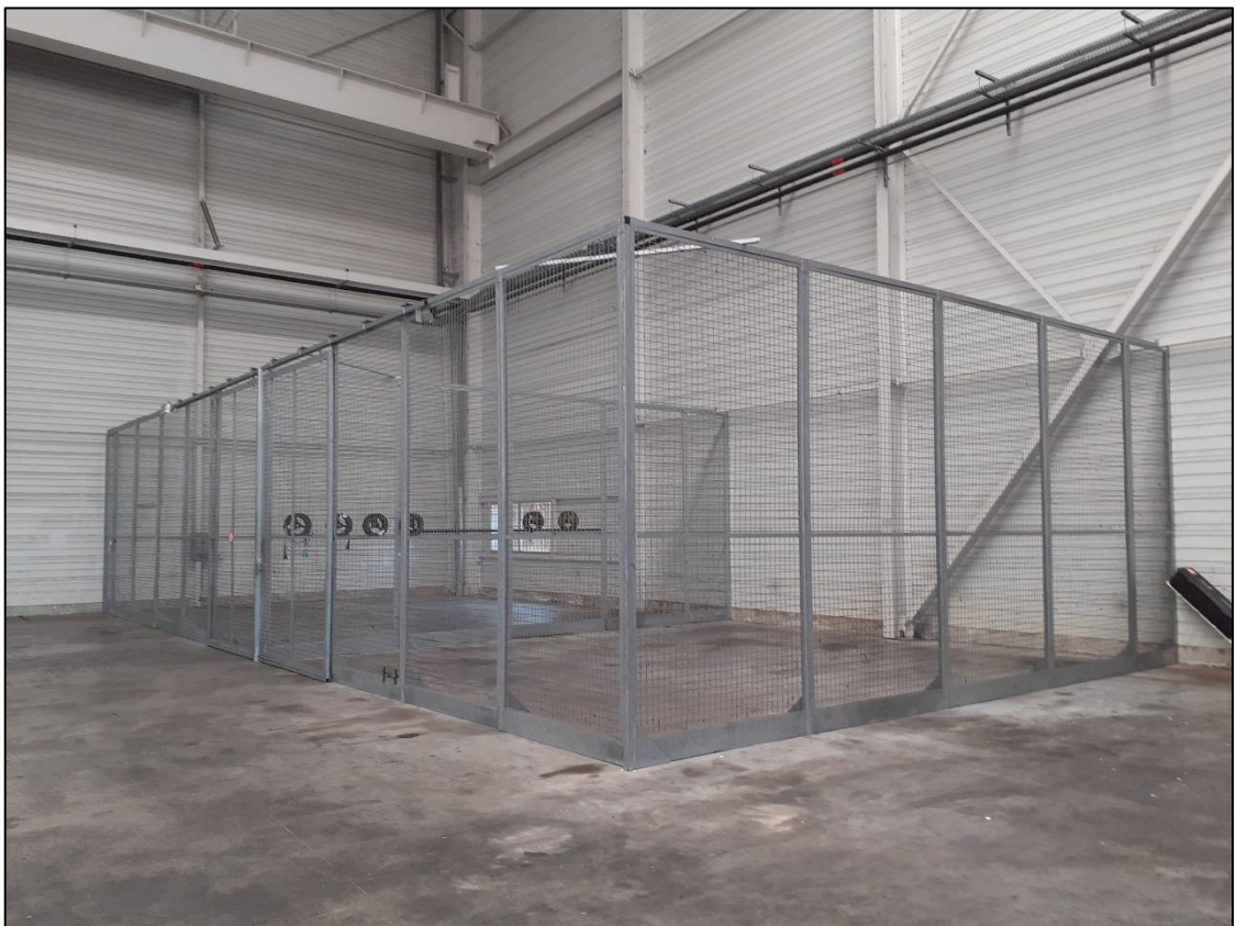
Figure 15 : Deux zones sécurisées (cloisons grillagées, orienté Sud-Est.
