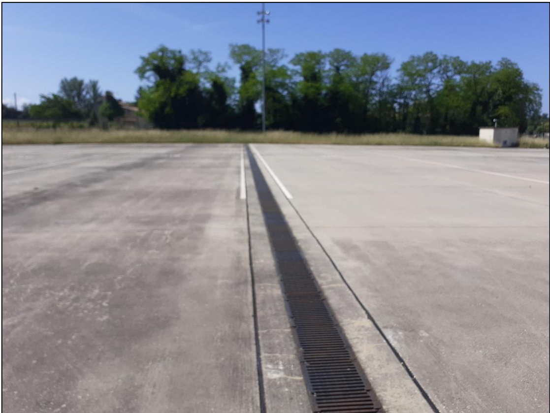
Figure 7 : Système d'écoulement des eaux en cas de crue, limite de la partie inondable de la plateforme
