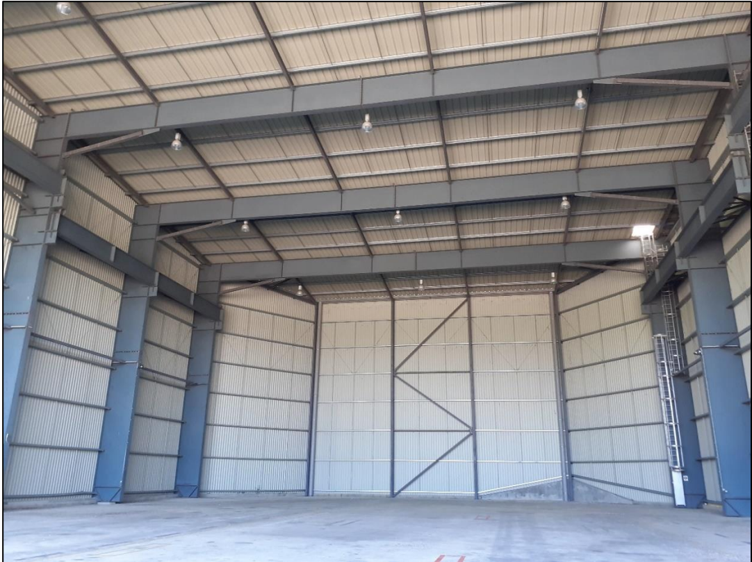
Figure 9 : Vue intérieure du hangar (vue de la cloison Nord-Est, située à l'opposé de l'ouverture).
