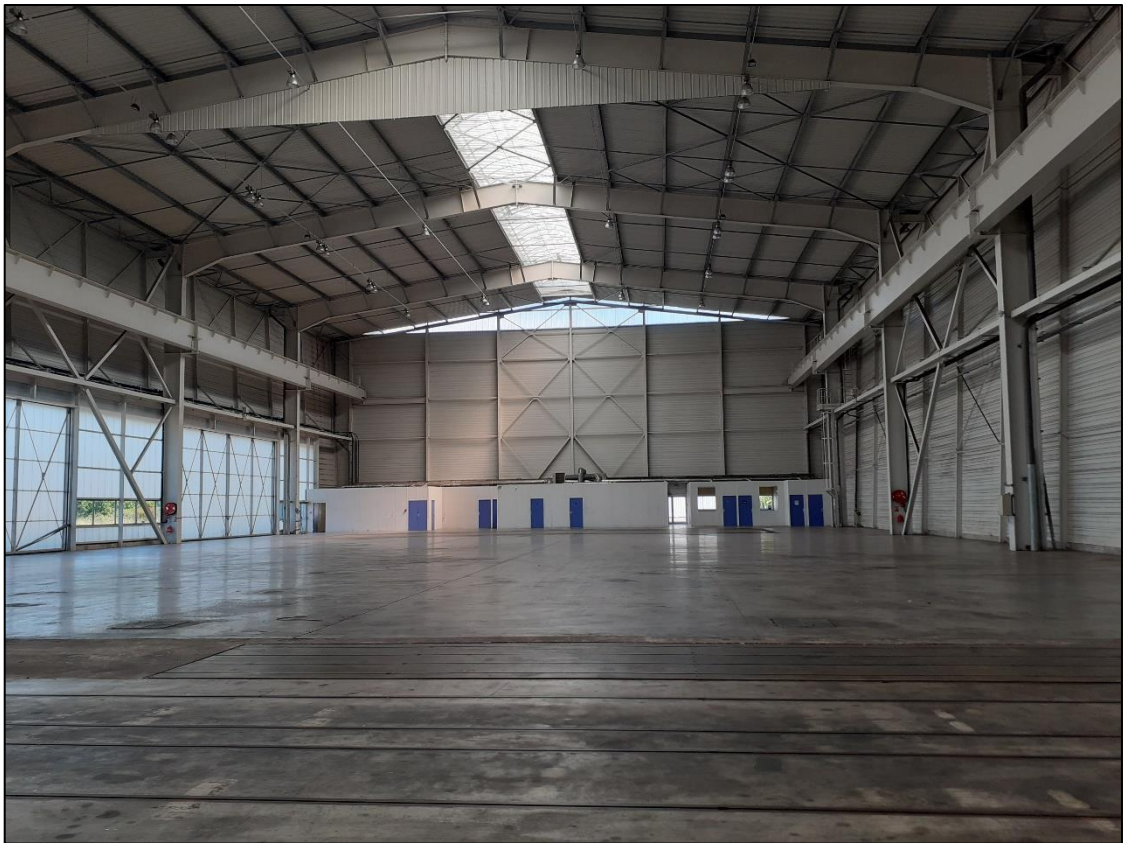
Figure 13 : Vue intérieure de l'entrepôt de 3000 m 2 , façade Nord avec bureaux et sanitaires. Vue de l'emplacement pour pont roulant.
