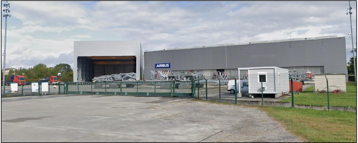
Figure 6 : Accès depuis la route et vue du système de sécurité (portail électrique, clôture avec retour et barbelés, éclairage et système de vidéo-surveillance).
