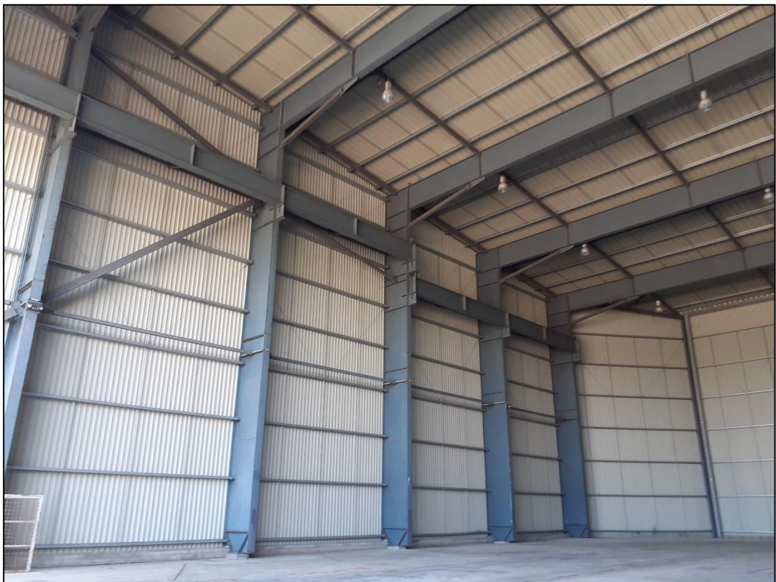
Figure 10 : Bâtiment 1, vue des emplacements pour ponts roulants (cloison Nord-Ouest).
