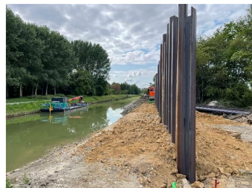
Travaux de confortement et installation de palplanches
