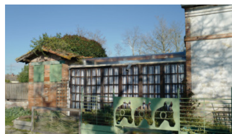
extension récente et vitrée reliant le bâti au pigeonnier et créant un volume fermé utile à l'activité artistique du locataire. [ME 8bis Verlhaguet, atelier, Lacourt-Saint-Pierre]
