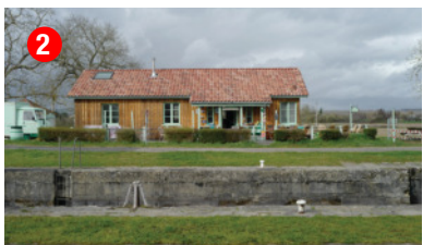
[ancienne maison du contrôleur de Bassanne]
