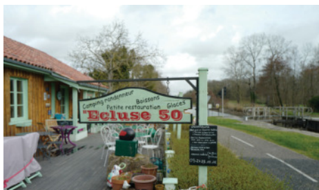
une situation courante et favorable avec une voie-vélo aménagée située directement devant le bâti [Ancienne maison du contrôleur de Bassanne]
