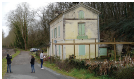
pergola en bois et haie végétale basse délimitant une terrasse de café ouverte. [ME 47 Gravières, L'Escale, Meilhan-sur-Garonne]
