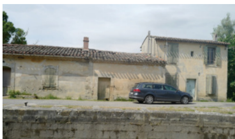
une situation plus contrainte avec une voie située devant le bâti [ME de Laurens, Mas Saintes Puelles]
