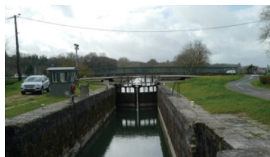
[pont de l'écluse de Bassanne]
