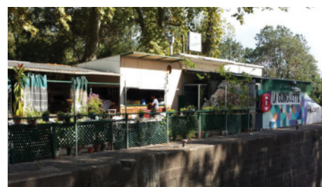
construction nouvelle démontable sur du foncier disponible en périphérie du centre-ville. Il s'agissait d'une guinguette, aujourd'hui démontée, aux abords du canal. [Ancienne guinguette de Prades, Agde]
