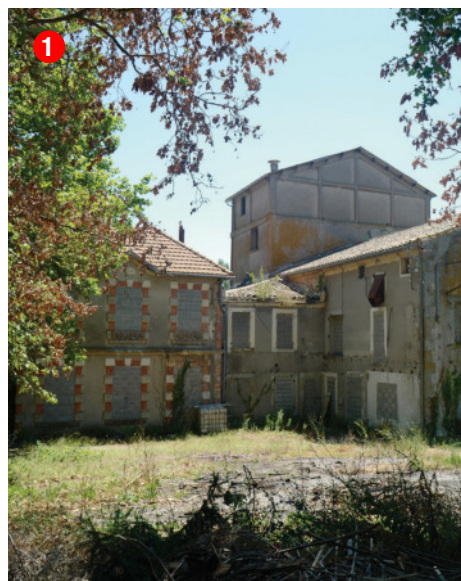
[ancien moulin et pavillon de Trèbes]
