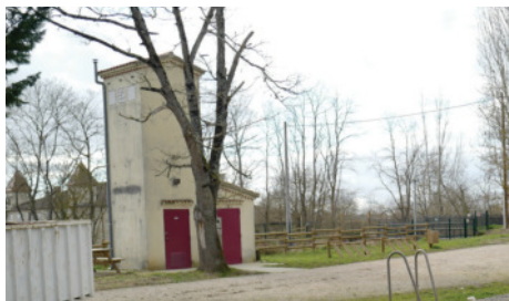
ancien transformateur EDF réhabilité en sanitaires publics le long de la voie vélo et à proximité d'une halte nautique.
