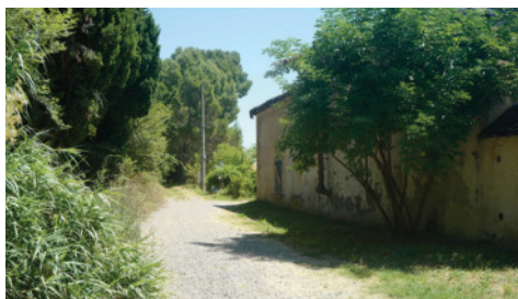
une situation plus contrainte avec un accès limité au chemin de halage et/ ou une piste cyclable non aménagée devant le bâti [ME de Fonfile, Blomac]
