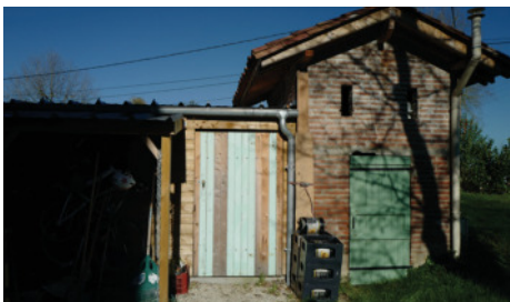
pigeonnier utilisé comme local de stockage dans le cadre d'une activité de restauration.
