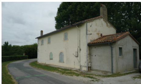
une situation favorable avec une voie située à l'arrière du bâti [ME du Sanglier, Ayguevives]
