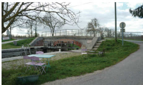
une situation courante et favorable avec une voie située sur le côté du bâti et connectée à un pont traversant la voie d'eau [ME 17 de Saint-Martin, Castelsarrasin]
