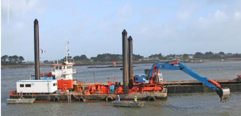
Figure 5 : Illustration d'un dragage mécanique d'une pelle sur ponton (source : VNF)
