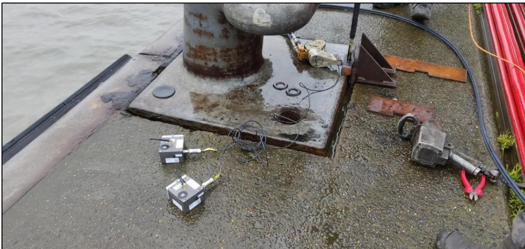
FIGURE 2 : INSTALLATION D'UN BOLLARD MONITOR
