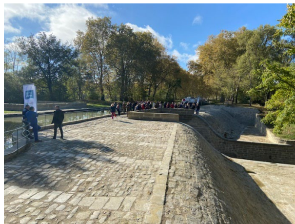
©VNF Visite commentée des travaux avec vue sur les déversoirs
