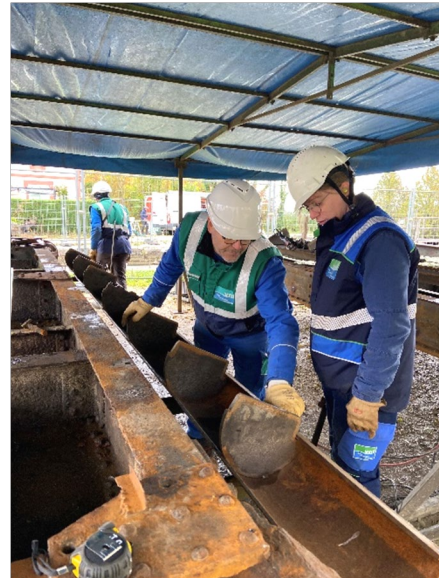
Changement des poteaux tourillons des portes de l'écluse de Saint Martin ©VNF
