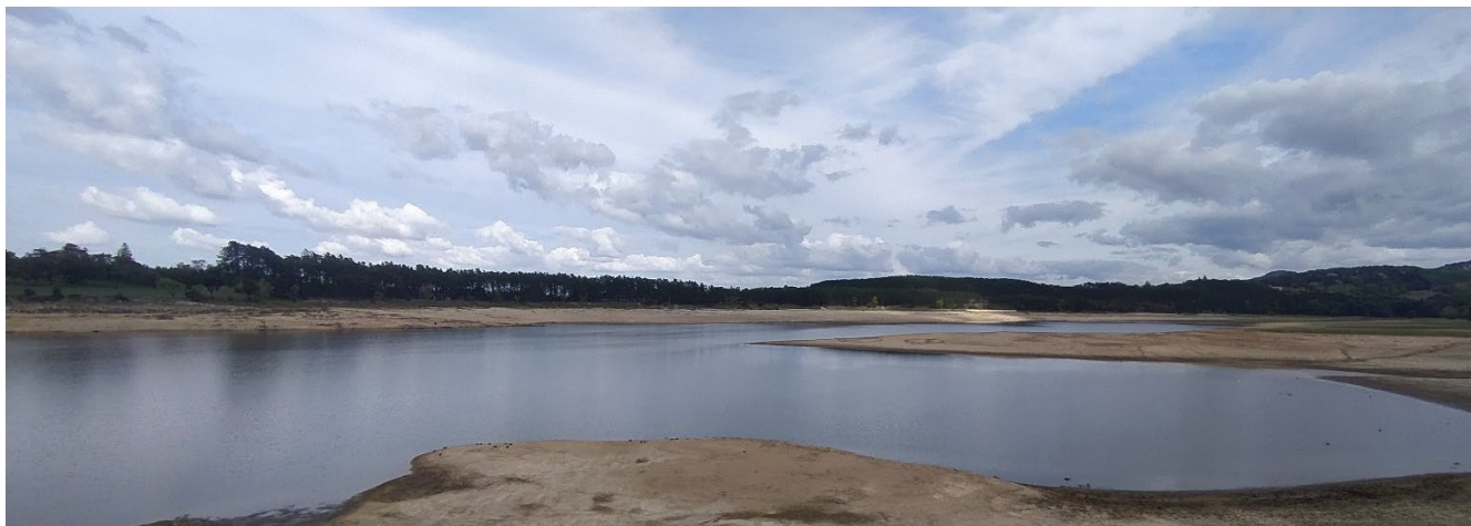
©VNF - Le barrage-réservoir de Saint Ferréol en octobre 2022
