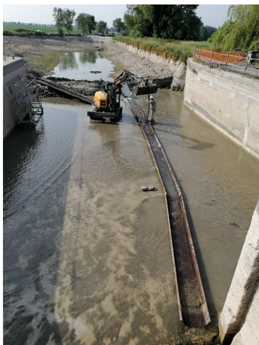
Pont canal de Noyelles-sur-Escaut : dispositif de maintien des écoulements d'eau vers l'aval de l'écluse
