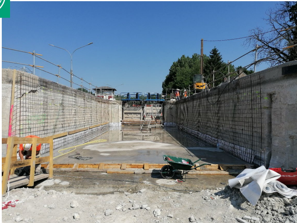
Pont canal de Noyelles-sur-Escaut : préparation des parements verticaux avant mise en œuvre d'un béton projeté de protection
