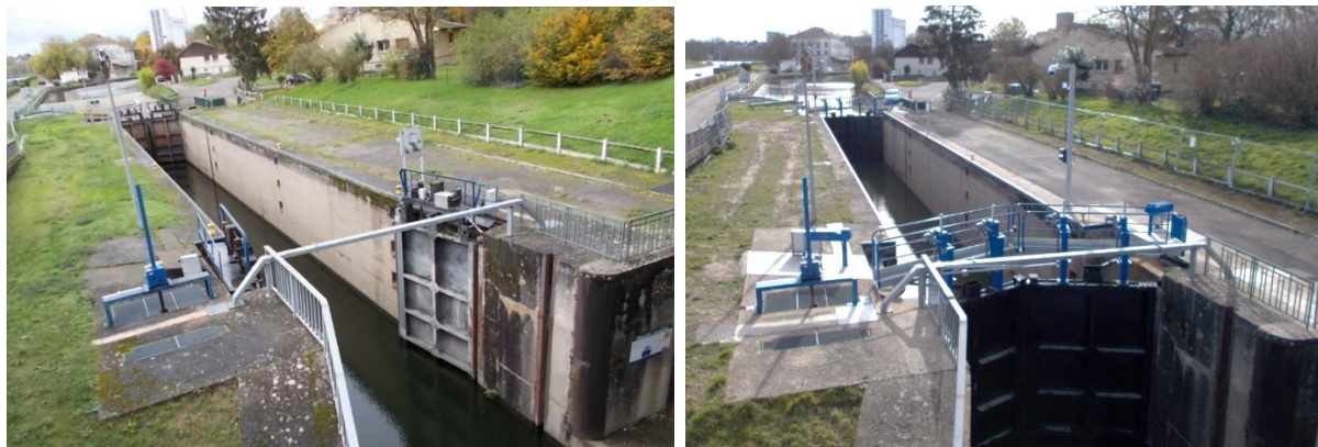
Vue de l'écluse avant travaux (gauche) et après travaux droite).
