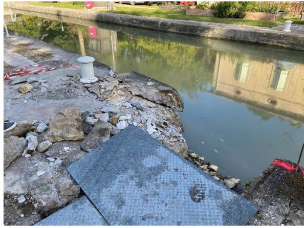
*Incident à l'écluse du Petit Bézy – Travaux de maçonnerie avec retrait des portes de l'écluse*
