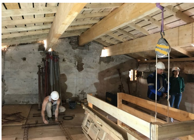
©VNF – travaux de charpente et plancher
