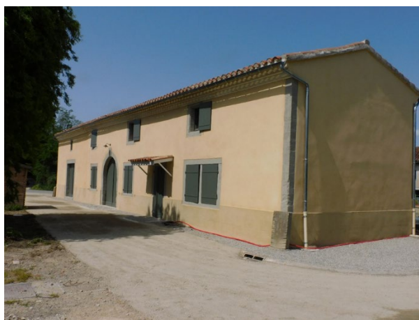
©VNF – les façades et enduits restaurés
