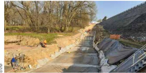
Le barrage réservoir de Bouzey a fait l'objet d'importants travaux en vue de sécuriser l'ouvrage et augmenter sa capacité de stockage. Avec ces travaux, la capacité maximale de retenue d'eau du réservoir pourra atteindre 7 millions de mètres cubes d'eau stockée contre 4 millions jusqu'alors. Le budget global de ce programme de travaux s'élève à 5,7 M€.
