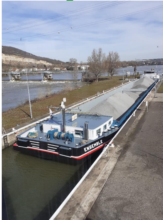
Travaux de l'écluse terminés durant le chômage de mars 2023
