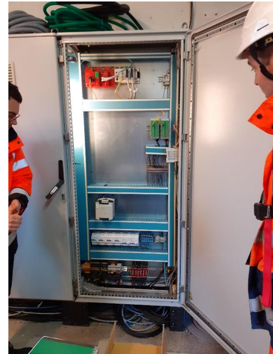
Travaux du barrage d'ici fin 2023 (retard d'approvisionnement des automates)
