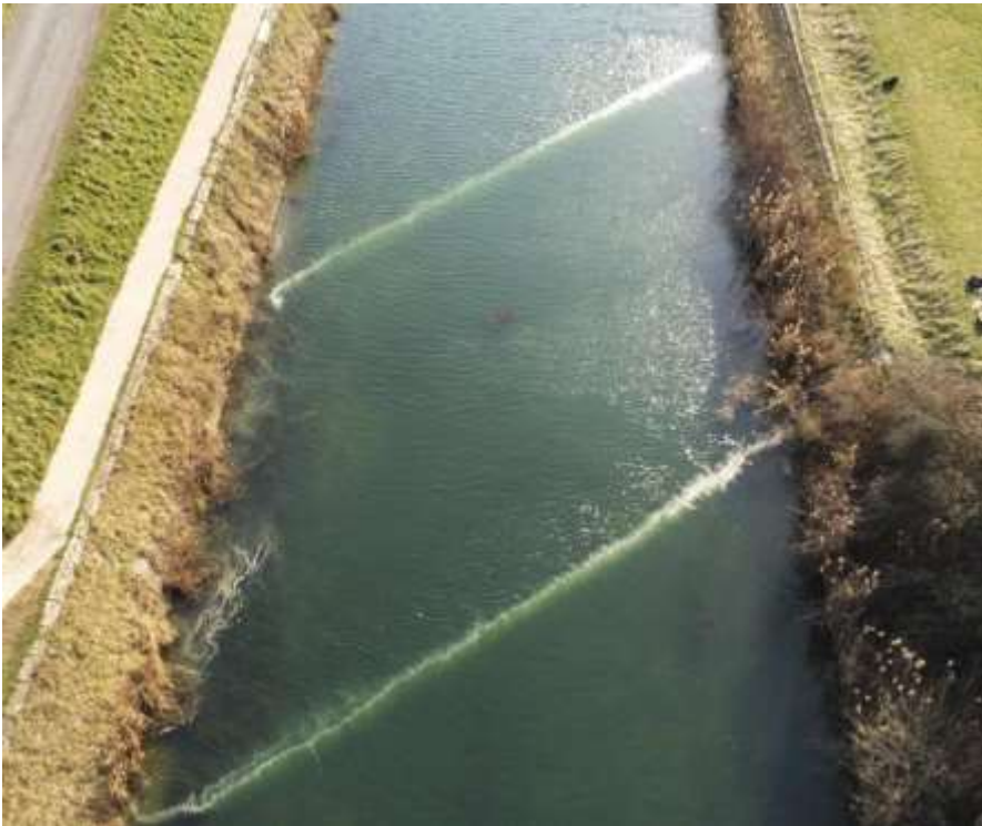
Rideaux de bulles pour empêcher la sortie du colorant vers la Saône
