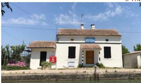
© VNF – site éclusier de Montech
