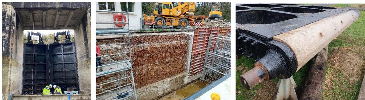
*1. Changement des portes de l'écluse de Saint-Aignan 2. Travaux de génie civil – écluse de Semuy. 3. Etanchéité bois réalisée en régie – écluse de Montgon (Crédits photo : Voies navigables de France – 2023, 2024).*
