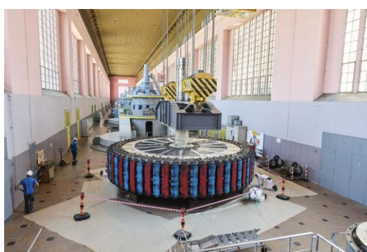
Sortie d'un stator ©Ph.Loertscher
