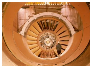
Groupe de production en cours de montage (1973) ©Archives EDF
