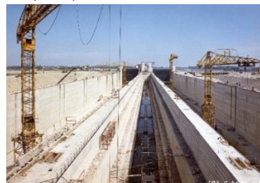
Vue d'un sas en construction ©Archives EDF
