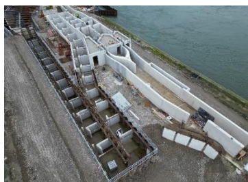
Chantier de la passe à poissons de Rhinau ©EDF
