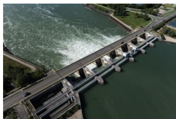
Vue aérienne barrage ©airdiasol
