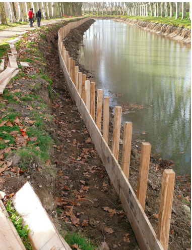
© VNF, Travaux de berges en vidange partielle
