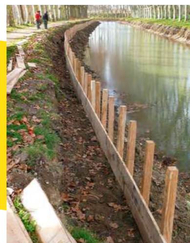
© VNF, Travaux de berges en vidange partielle
