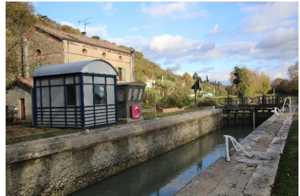
Remplacement de l'édicule – Ecluse Petit Bézy ©VNF
