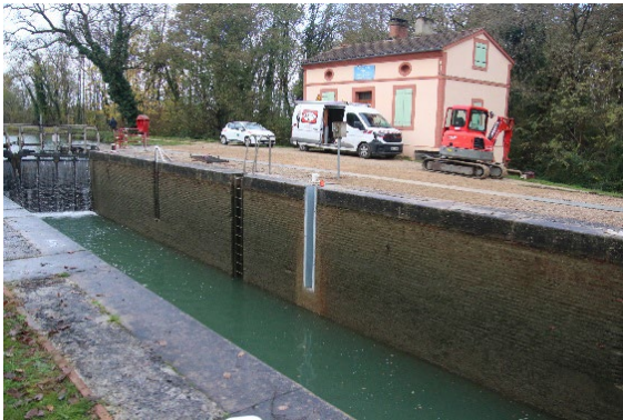
Pose de tirettes de sas – Écluse 1bis à 9bis ©VNF
