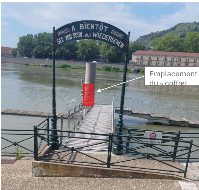
Tain l'Hermitage : Montage avec l'emplacement du coffret
